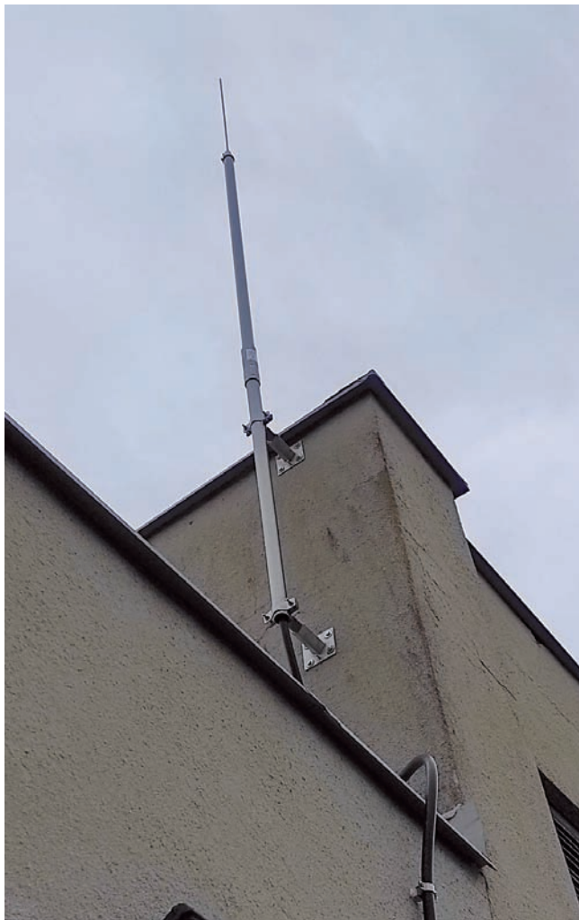
Obr. 3 Moderné riešenie ochrany pred bleskom a prepätím
