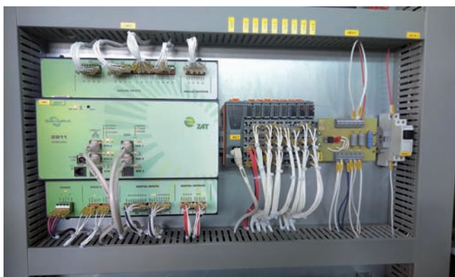
Kompaktný regulátor turbíny SandRA CTC (vľavo)
