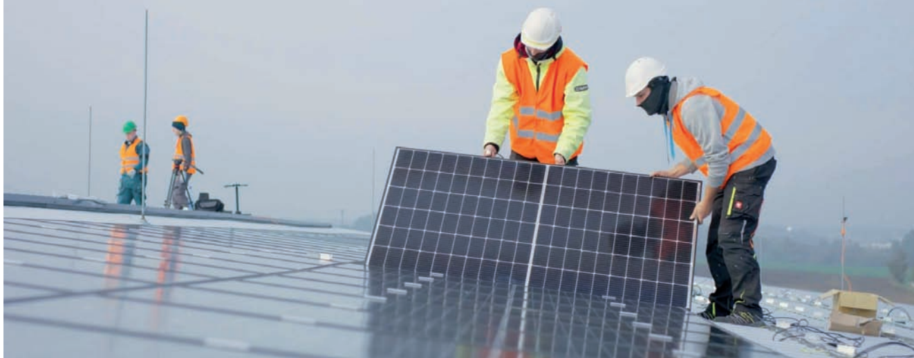
Na streche novopostavenej budovy je umiestnených 270 fotovoltických panelov.
