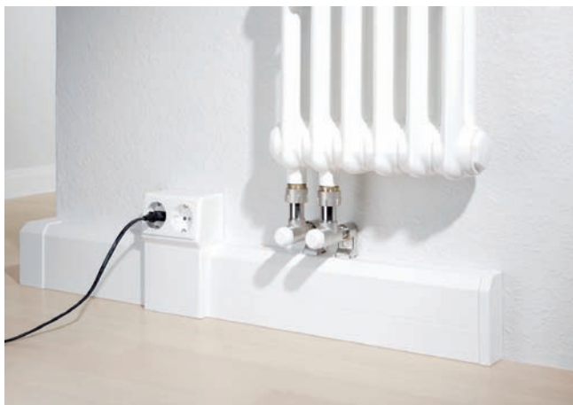
Príklad rekonštrukcie v starej budove, skryté rozvody kúrenia a elektriky v jednej lište.
