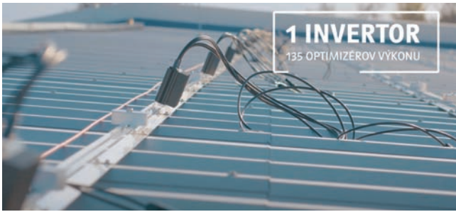
Optimálny chod FVE aj celkovú bezpečnosť prevádzky má na starosti 135 optimizérov a spoľahlivý menič Solar Edge.
