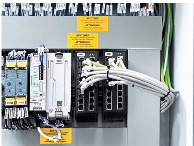
Pri spracovávaní veľkého množstva údajov vstupujú do hry 16-portové sieťové prepínače od spoločnosti Murrelektronik. (Zdroj: Murrelektronik)
