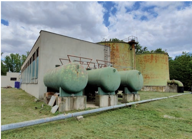
Obr. 1 Objekty závlhovej čerpacej stanice
