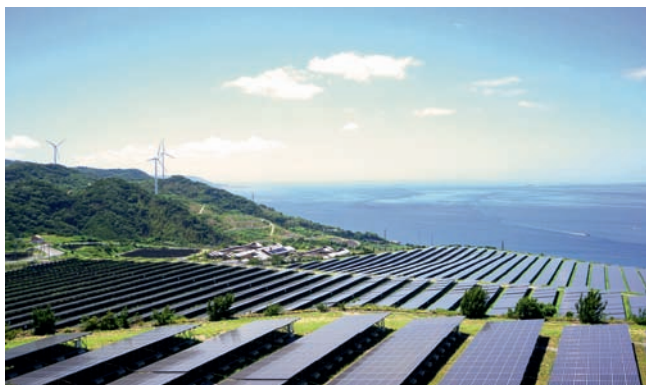
Obr. 2 Fotovoltaické systémy sa stále zväčšujú a ruka v ruku s tým idú aj zvýšené požiadavky na nainštalované komponenty.
